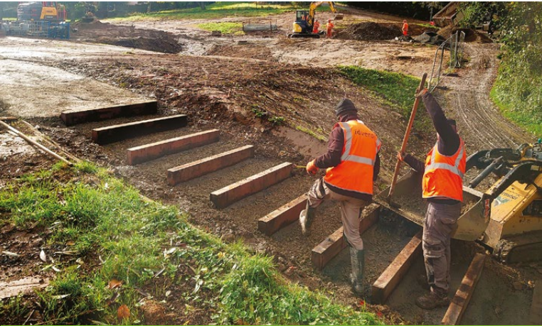
Mise en place de l'escalier descendant vers le bas de la salle Yves Guégan
