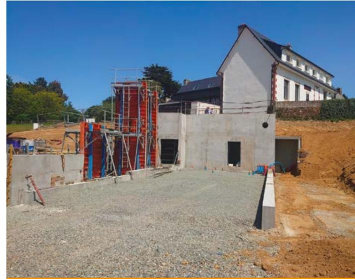
Gros œuvre en béton banché pour stabiliser l'édifice et le terrain
